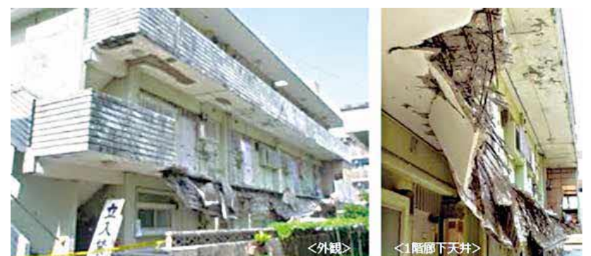
▲マンション2階の廊下が崩落している
